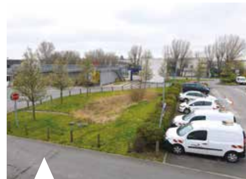
Noue mise en place au Centre Technique Communautaire
