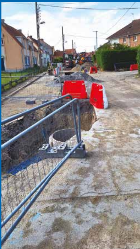
Bourbourg, rue de Verdun. Réhabilitation et déconnexion
